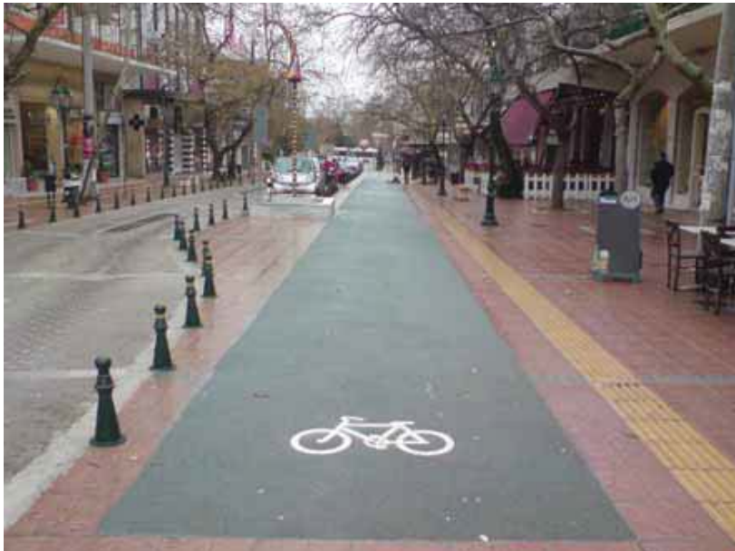
Κηφισιά. Διαμόρφωση δρόμου σε ήπιας κυκλοφορίας όπου η κίνηση των οχημάτων οριοθετείται με μεταλλικά κολωνάκια και το υπόλοιπο τμήμα του οδικού χώρου κατανέμεται σε αμφίδρομο ποδηλατόδρομο και πεζόδρομο κοινής στάθμης.
