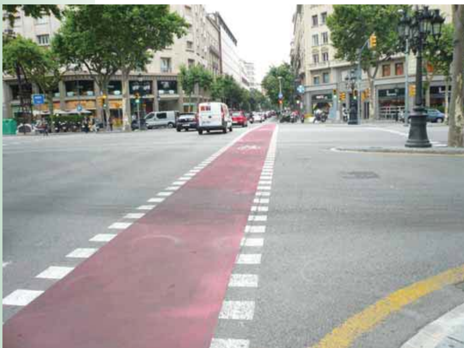
Βαρκελώνη. Διάβαση ποδηλάτου με διαγράμμιση και κόκκινο τάπητα
