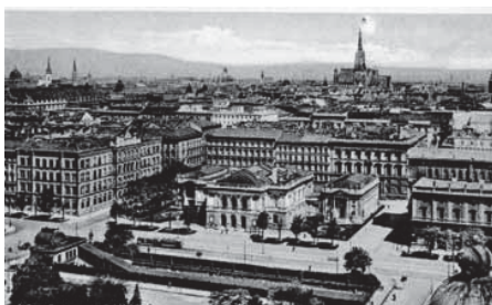
Βιέννη, όψη από την Karlskirche, φαίνεται το ανοικτό όρυγμα του μετρό και η είσοδός του σε σχέδια art nouveau του Wagner (Πηγή: καρτ-ποστάλ του Μεσοπολέμου).
