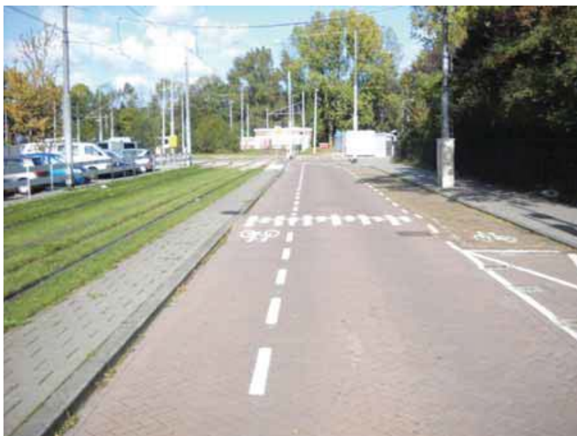
Φρανκφούρτη. Διαμόρφωση δρόμου με τιμμεντένιους χρωματιστούς κυβόλιθους για συνύπαρξη διαφόρων κατηγοριών χρηστών.
