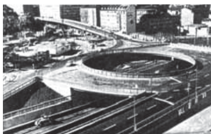
Österreichischeplatz, στην Στουτγκάρδη μεταλλαγμένη σε ανισόπεδο κόμβο. (Πηγή: Bockelmann...)
