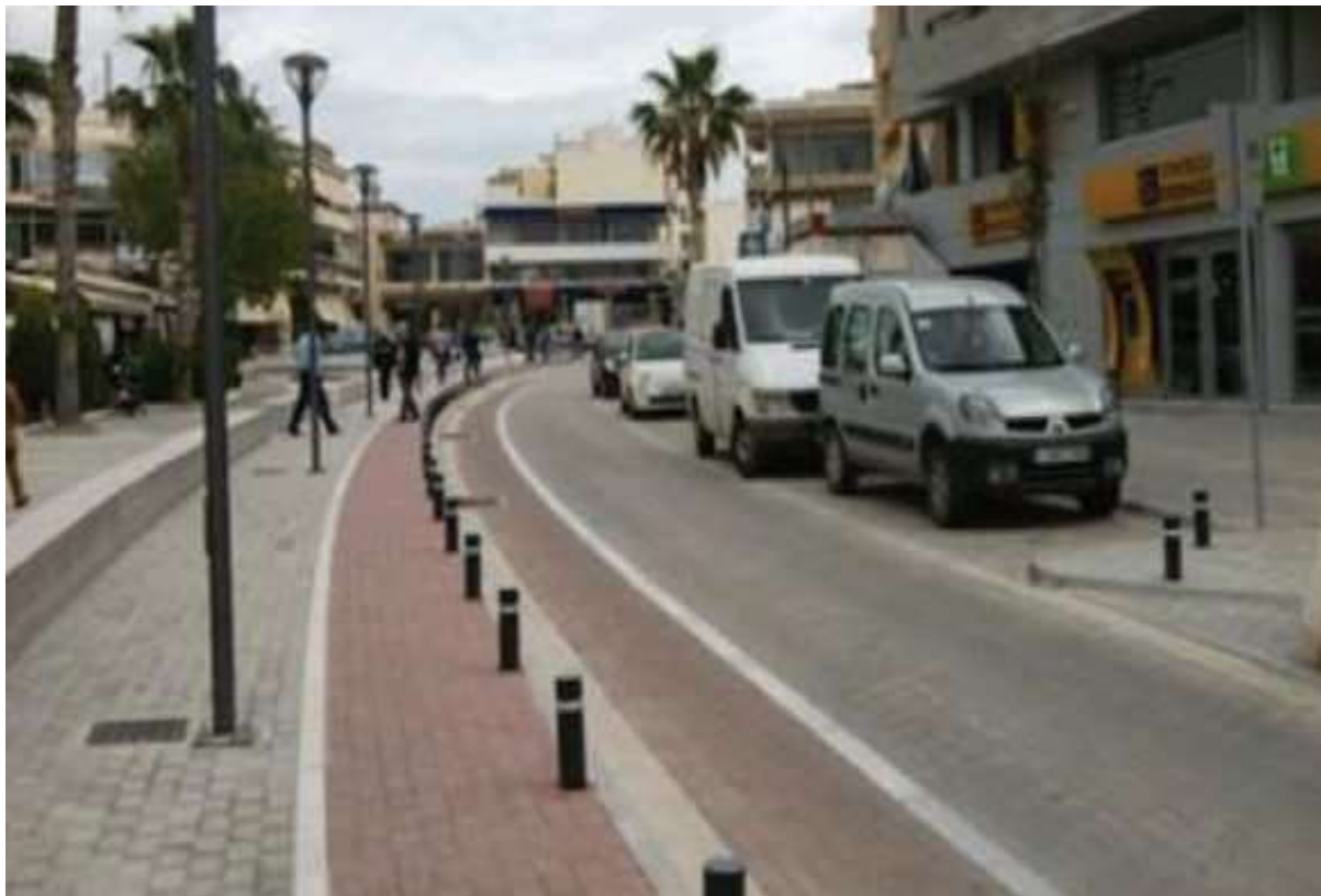
ΕΙΚΟΝΑ 2. Ποδηλατόδρομος στην κεντρική πλατεία του Μαρκόπουλου Αττικής. Υποχρεωτική αντίρροπη λωρίδα. Η ομόρροπη κίνηση γίνεται σε υποχρεωτική λωρίδα, επίσης, επί του οδοστρώματος.
